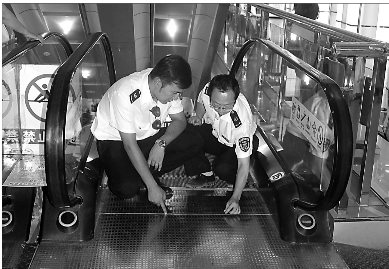
近日,新疆乌鲁木齐市质监局紧急排查该市的2000余部手扶电梯。要求电梯使用单位、维保单位吸取电梯事故的教训,切实落实安全主体责任,严格遵循电梯维保规程,确保电梯安全运行,加强公众安全意识教育,引导安全乘坐电梯,杜绝人身伤害事故的发生。据悉,本次紧急排查将持续至10月。图为执法人员对电梯踏板进行检查。
